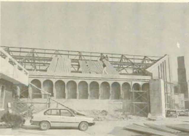
성전 외벽 및 지붕 공사(83년 12월 20일)
