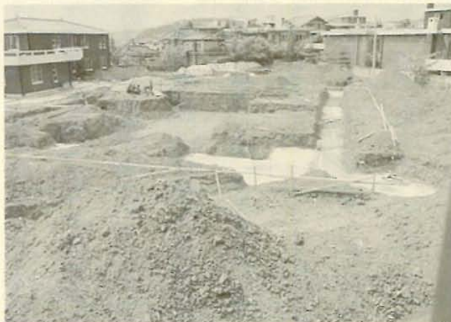
성전 기초 터파기 및 규준틀 매기 공사(83년 7월 3일 촬영)
