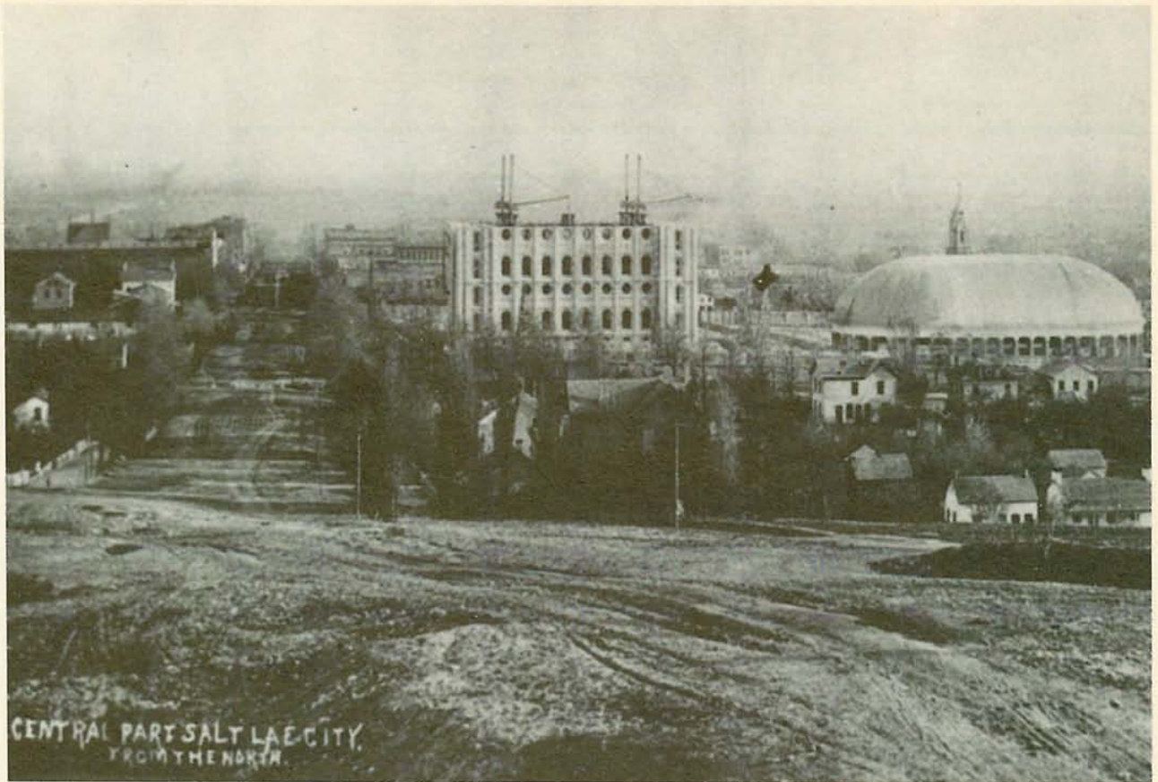
회강암을 제자리에 올려 놓기 위해 데릭스(수동식 기중기)가 사용되었다. 1880년대에 찰스 알 새비지가 촬영한 사진(위)에서 보면 최소한 기중기 한
